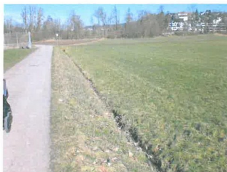
Abb. 5: Entwässerungsgraben (12.61) im Osten des Plangebietes
