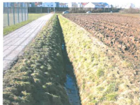
Abb. 6: Entwässerungsgraben (12.61) im Norden des Plangebietes
