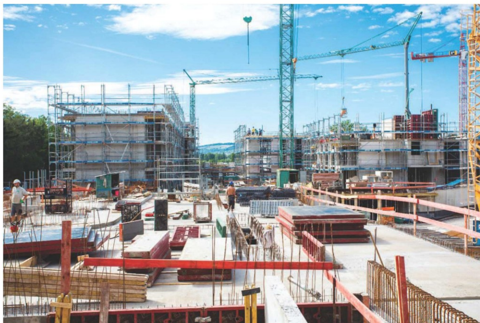
Die Baustelle an der Alfred-Leikam-Straße (ehem. Klinikareal Waiblingen)
