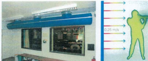
Beispiele mit textilen Luftauslässen
