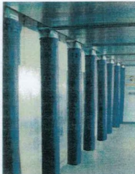
Beispiele mit textilen Luftauslässen
