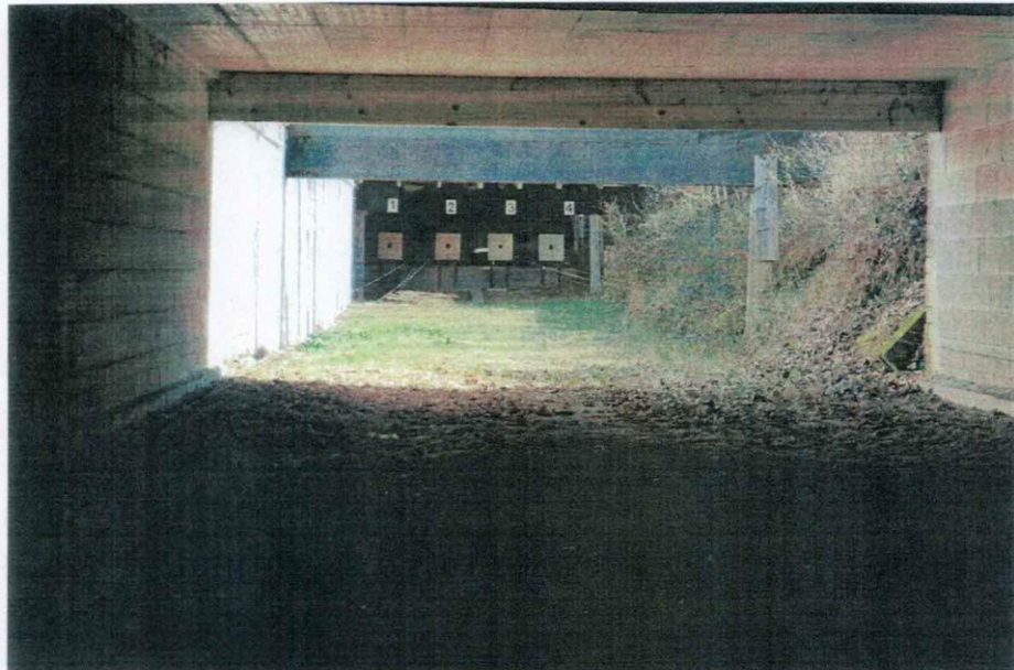
Ansicht der Anlage vom Schützenstand aus gesehen
