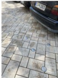
Multifunktionsfläche Betonpflaster mit Sickerfugen und Stellplatzmarkierung mit Alu-Kappen
