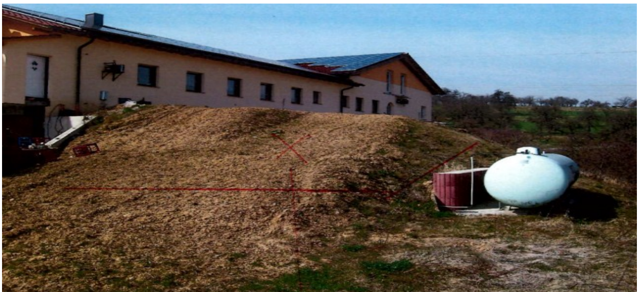
Erdauffüllung auf der Ostseite
