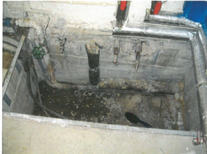
Abb. 1: Schacht im Technikraum
