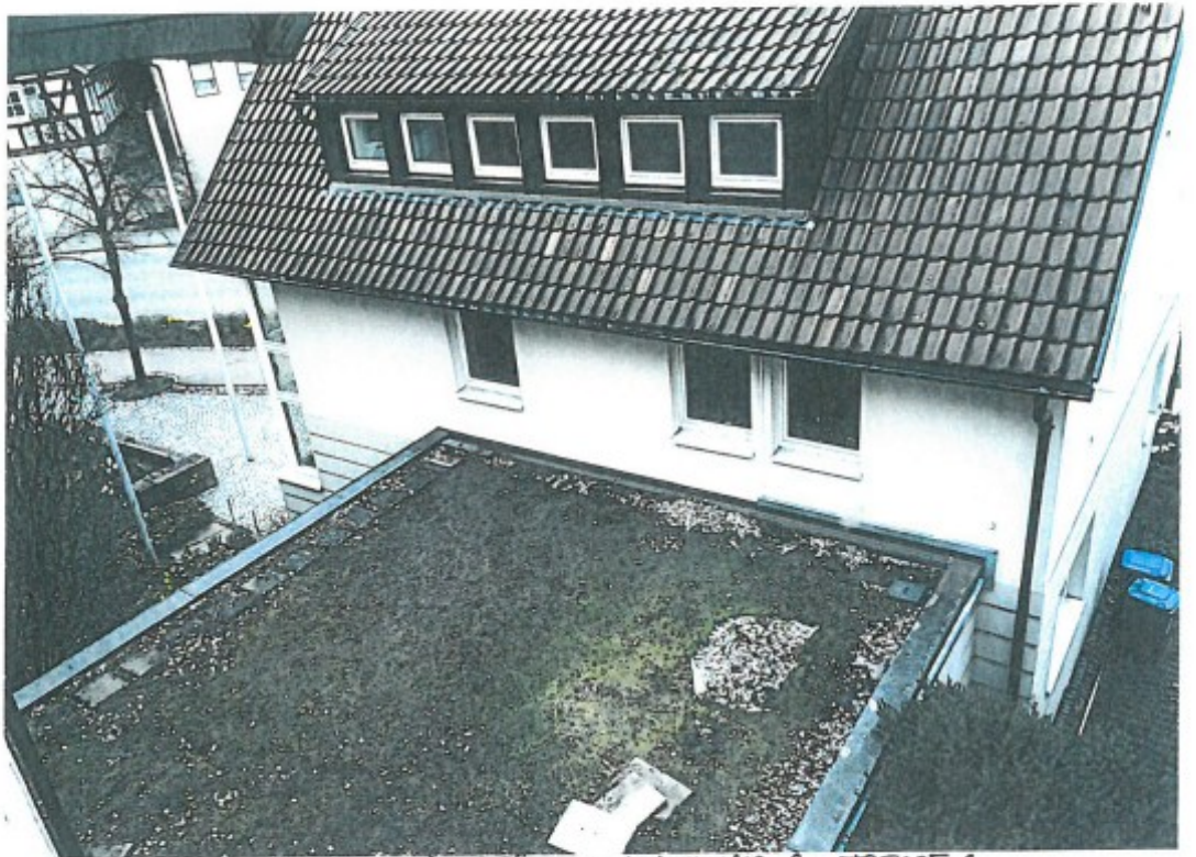
↑ GEBÄUDE BEETHOVENSTR. 20 TREPPE 2
